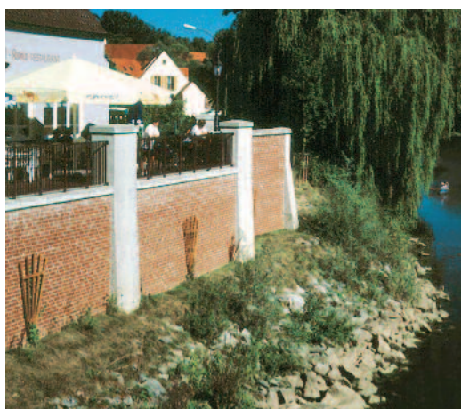
Hochwasserschutz durch Mauern...
